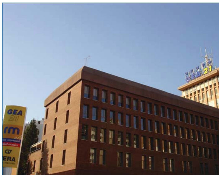
El Grupo Gea 21 cuenta con un gran centro en Sevilla, precisamente junto a una de las estaciones del Metro, en cuya construcción participa.
