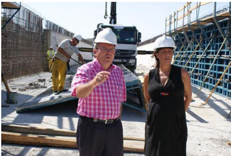
Antonio Bonilla y Sonia Rodríguez en las obras de Rambla Pastor
